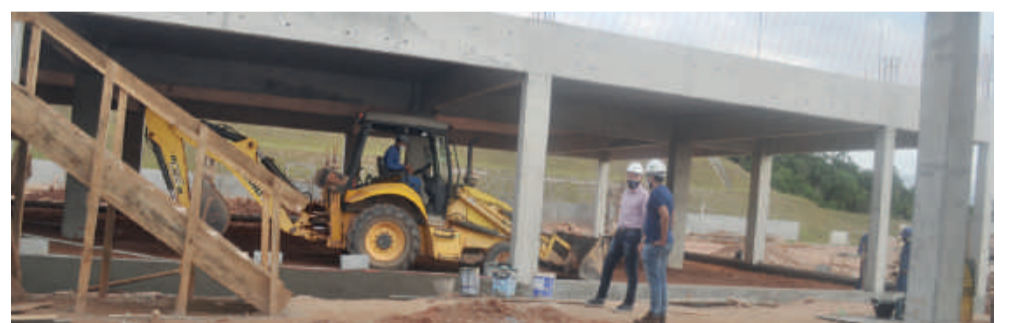
Prefeito Adriano Leite muito satisfeito com o ritmo acelerado das obras do Hospital, com percentual de medição em 22,83% concluídas, sendo executadas dentro do cronograma previsto
