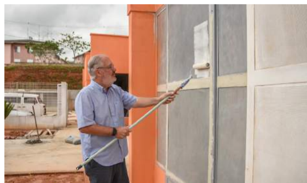
Prefeito Zé, em ação no retouque final da obra
